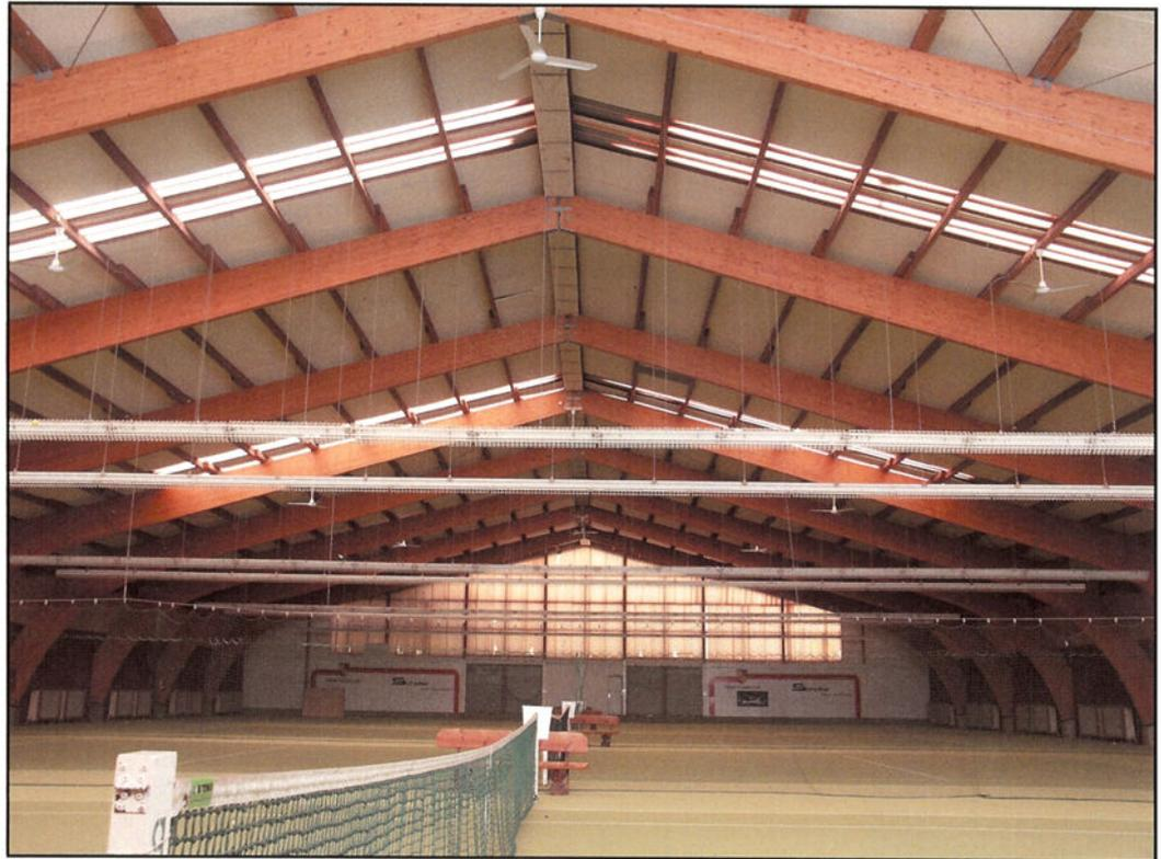
Industrie-Deckenventilator mit Schutzgehäuse, der für Tennishallen Vorteile gegenüber den offenen Deckenventilatoren bringt.
